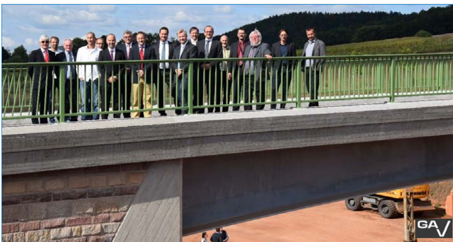
Projektbeteiligte aus Politik, Wissenschaft, Stahlindustrie, Stahlbau- und Feuerverzinkungsindustrie, Bauplanung und -ausführung begutachteten die erste fertiggestellte feuerverzinkte Stahlverbundbrücke in Deutschland.
